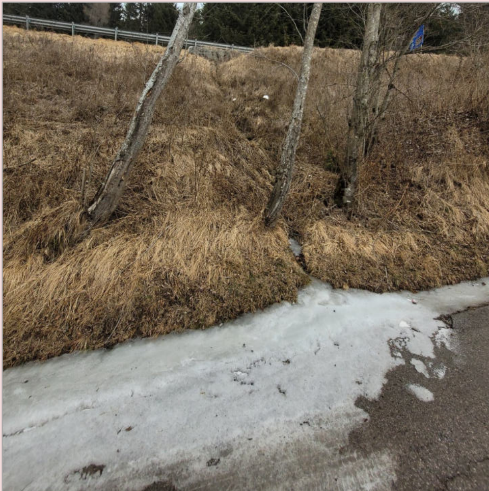
Figura 3: Scolo proveniente da SS52 che crea riversamento sulla carreggiata con formazione di ghiaccio
