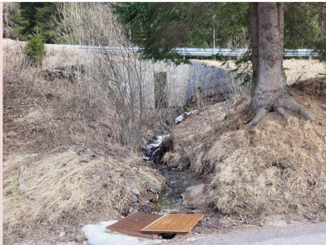
Figura 4: Rio che sottopassa la SS52 e viene convogliato in un pozzetto con attraversamento sotto la strada comunale
